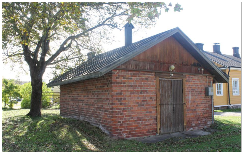
Kuva 53. Rakennus nro 16 pihan koilliskulmassa sijaitseva tiilinen jääkellari.
