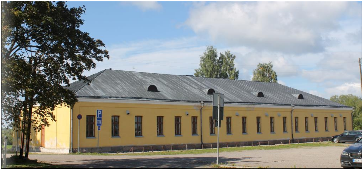
Kuva 42. Rakennus nro 1a, Vanha kasarmi.
