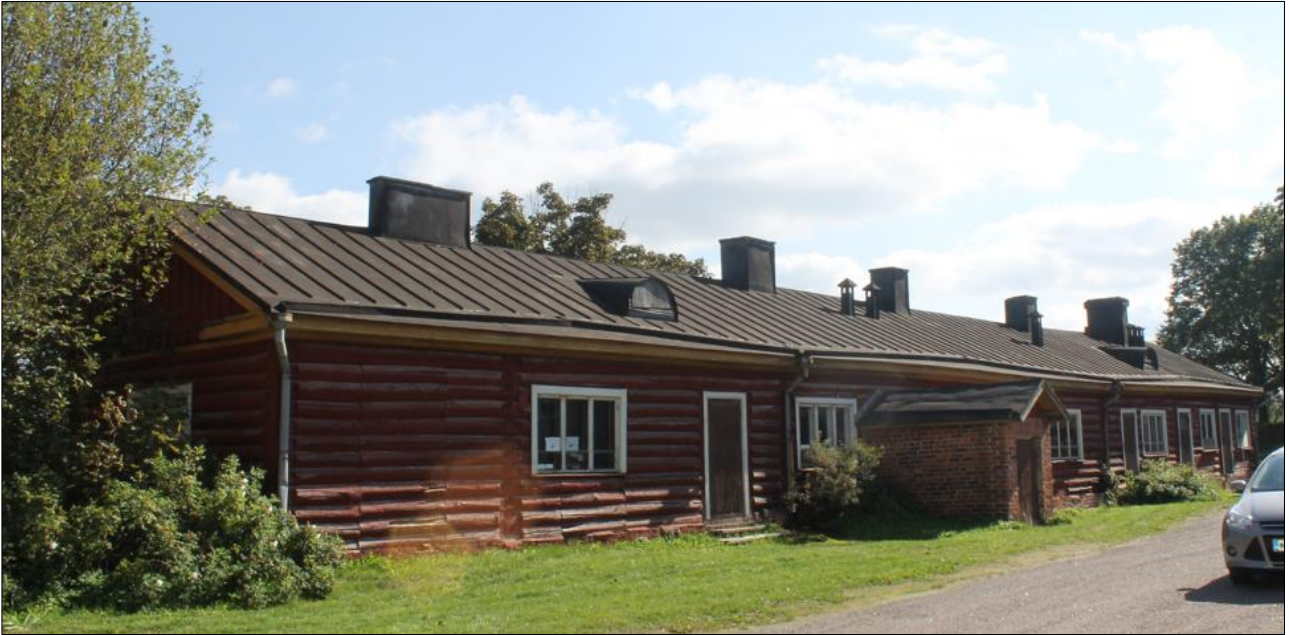
Kuva 66. Rakennus nro 56, Pilttuu.
