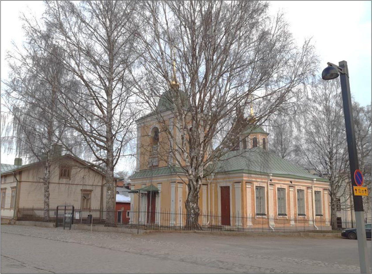
Kuva 81. Rakennus A, Ortodoksinen kirkko.
