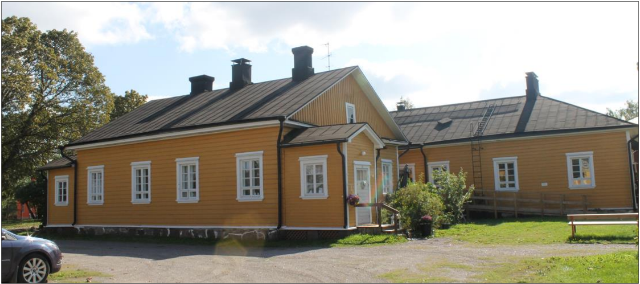
Kuva 52. Rakennus nro 16 luoteesta päin kuvattuna.
