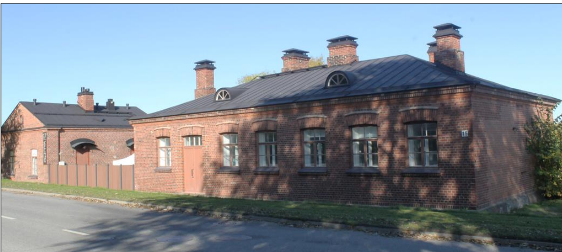
Kuva 80. Rakennus nro 94 Satamatoimisto.
