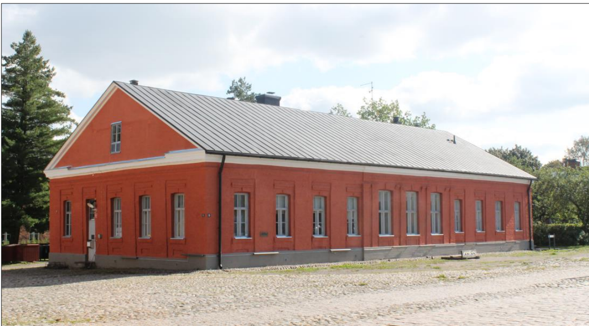
Kuva 85. Rakennus C, Käräjätalo.
