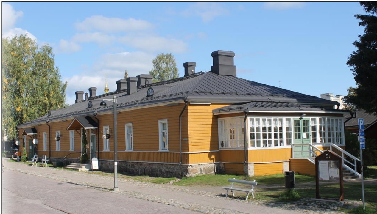
Kuva 65. Rakennus nro 55, Majurskan talo.
